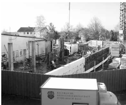
Bauarbeiten an der neuen Zerlegung
