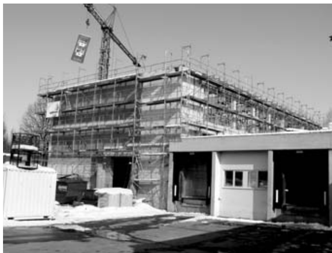
Rohbau der neuen Zerlegung
