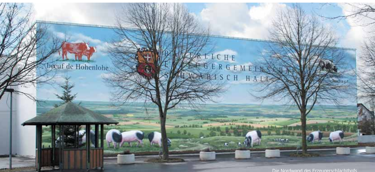
Die Nordwand des Erzeugerschlachthofs
