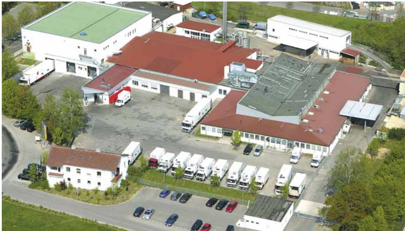
Nach abgeschlossener Sanierung mit 6,9 Mio Euro Investitionssumme befindet sich im Neubauteil des Erzeugerschlachthofs Schwäbisch Hall 1. OG und Produktionsteil Bauernmarkt der neu geschaffene Produktionsbereich Fleischverarbeitung und Wurstherstellung.
