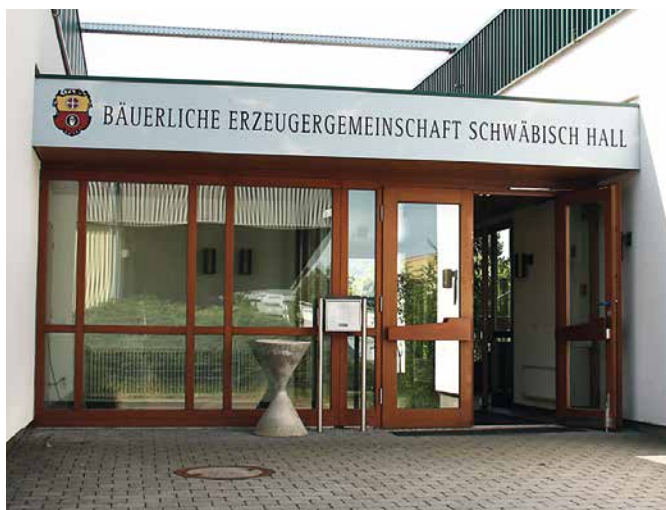
Der Eingangsbereich in der Raiffeisenstraße 12.
