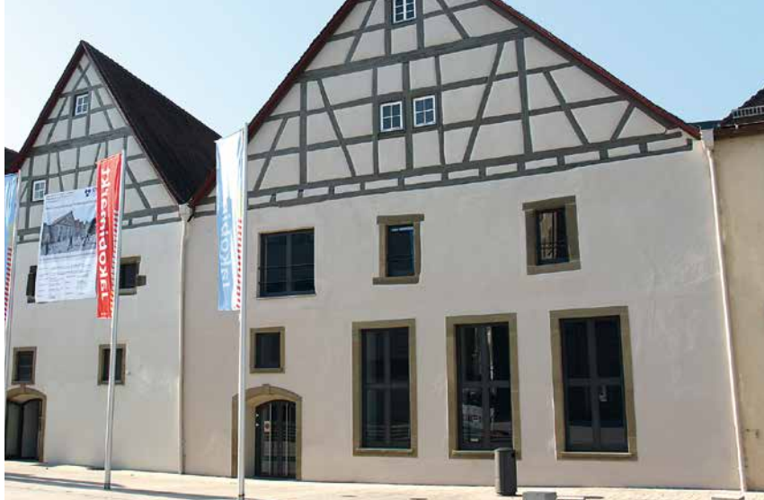
Der Bereich der Kornhausscheunen, in der sich die Bäuerliche Erzeugergemeinschaft präsentieren wird. Bild rechts Eingang von der Kornhausstraße, oben Ansicht vom Kocherquertier.
